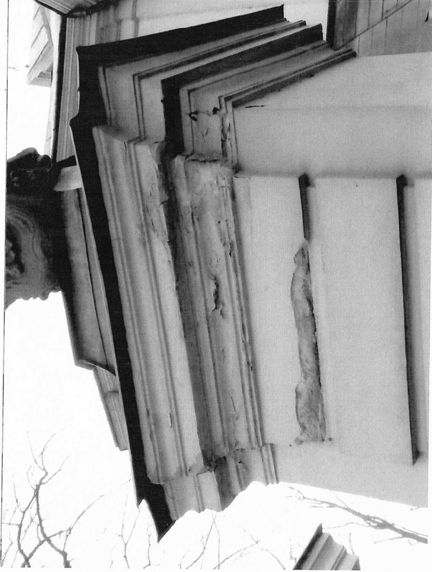
Fot.6 Kościół parafialny p.w. św. Marii Magdaleny w Dukli, II poł. XVIII w. Zwieńczenie jednego ze słupów ogrodnika. Widoczny ubytek tynku na boniowaniu, a na gzymsie przetarcia, złuszczenia i ubytki farby. Fot. P. Michalski Grudzień 2023 r.
