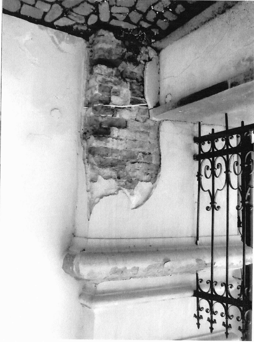
Fot.3 Kościół parafialny p.w. św. Marii Magdaleny w Dukli, II pol. XVIII w. Dolna część pilastra północnej elewacji dzwonnicy. Widoczny duży ubytek tynku i cegieł. Na półwałku powyżej, ubytki farby z widocznymi nawarstwieniami mchu. Grudzień 2023 r. Fot. P.Michałski
